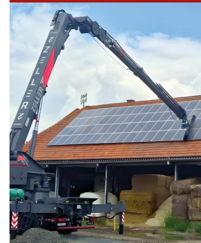
Mit einer Reichweite von 36m erreichen wir jedes Solarmodul auf den Dächern mühelos.
